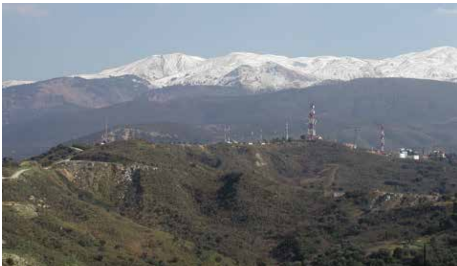
Κέντρο Εκπομπής Αρόη του Ν. Αχαΐας (Φωτογραφία Α. Αγγιούς, Δ/ση Φάσματος EETT)
